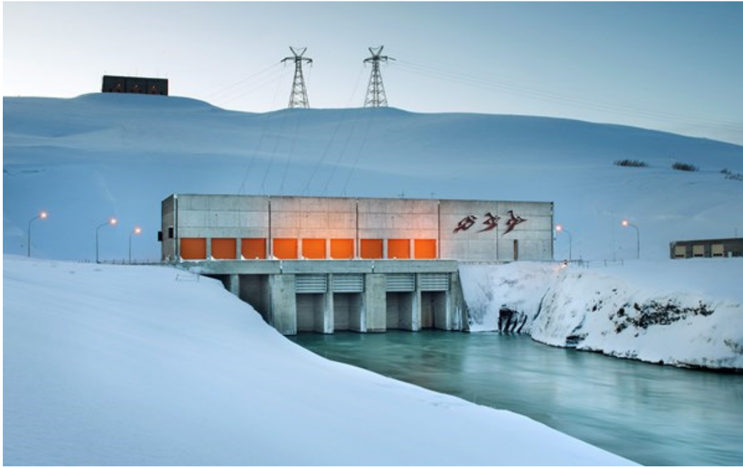
Mynd 9.4-4: Hrauneyjafosstöð 210 MW (Landsvirkjun.is, 2014).
