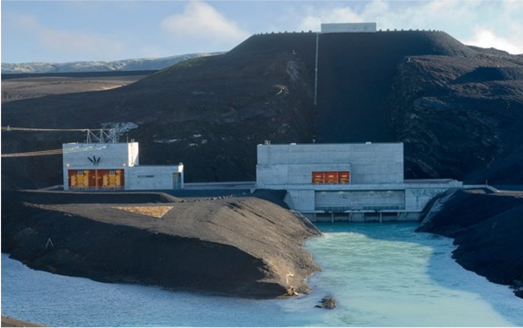
Mynd 9.3-3: Vatnsfellsstöð 90 MW (Landsvirkjun.is, 2014).
