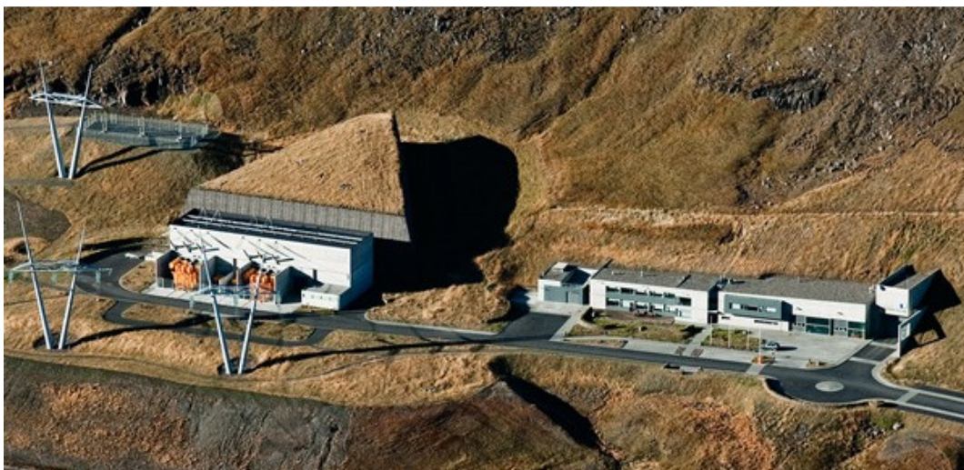
Mynd 9.5-5: Fljótsdalsstöð 690 MW (Landsvirkjun.is, 2014).
