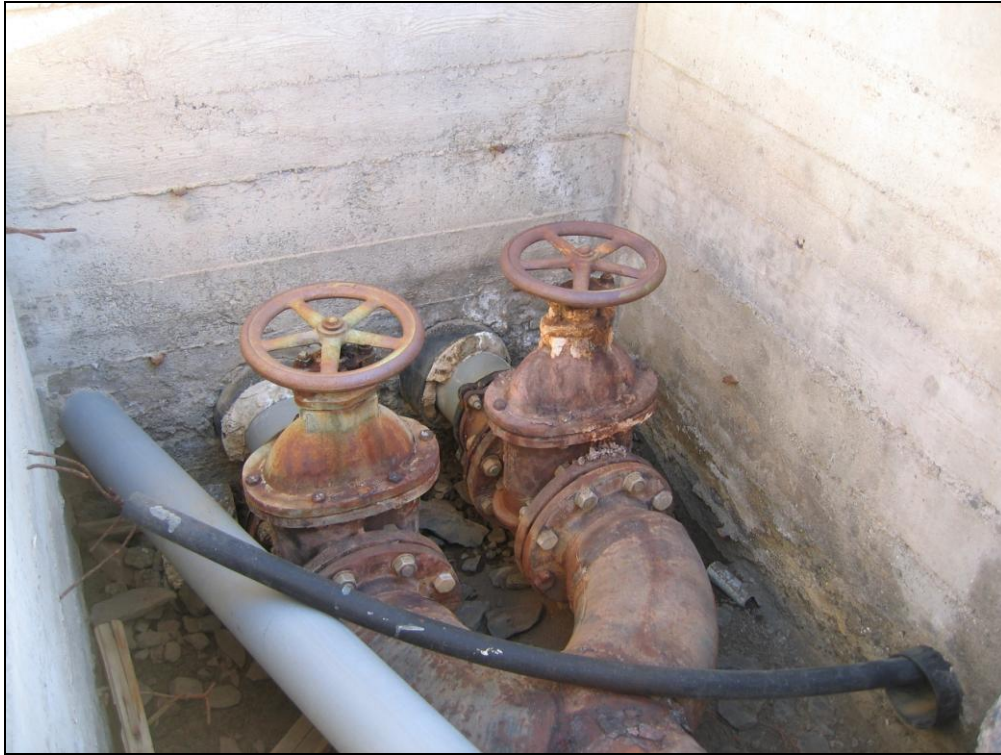
Mynd 115. Borhola RV-01 á hlaðinu framan við skólabygginguna í Reykjanesi.
